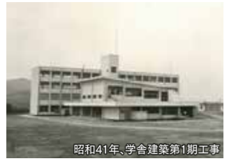
昭和41年、学舎建築第1期工事
