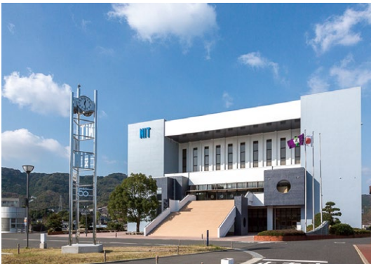
③ L 棟 (総合体育館)
