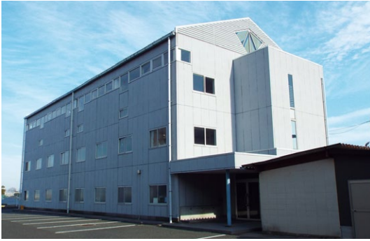
P棟（サークル・委員会室）
